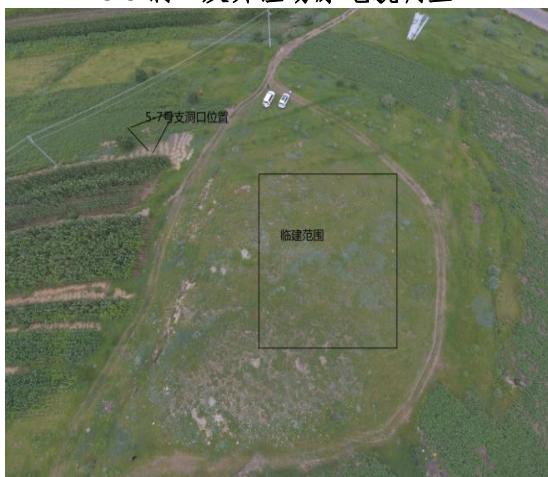
5-7 洞口及弃渣场原地貌调查
